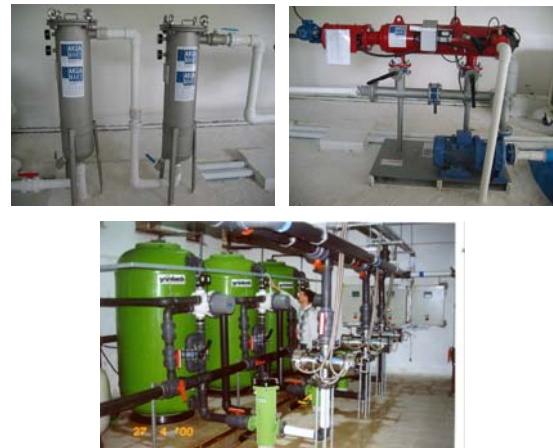
Şekil 2. Üstte soldaki resim torba filtreyi, sağdaki kendini temizleyen otomatik filtreyi göstermektedir. Altta seri montajlanmış halde kum filtre, kartuş filtre ve UV düzeneği yer almaktadır.
